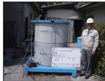
水密性試験 (1号マンホール 0.1 MPa・3分)
